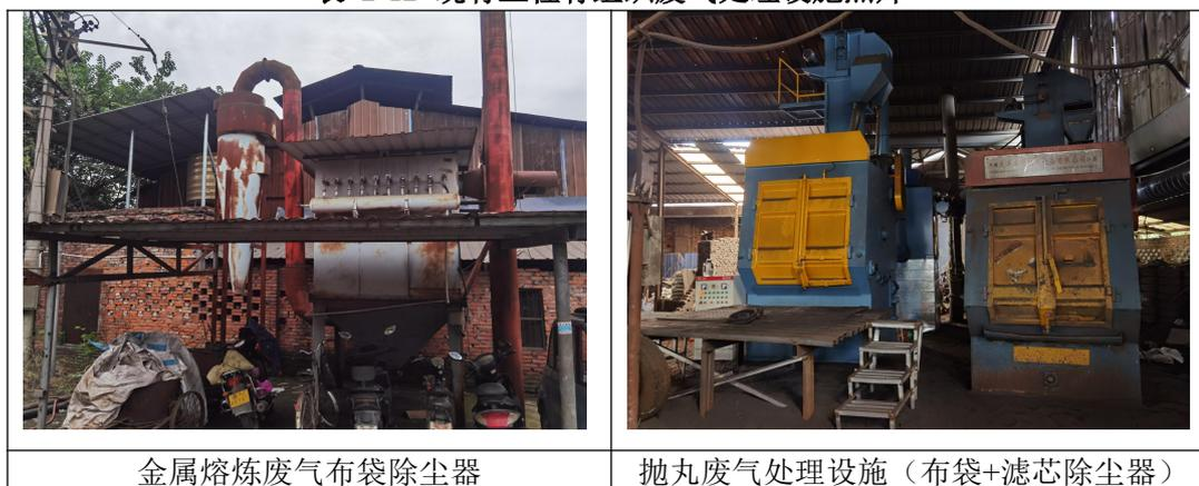
金属熔炼废气布袋除尘器
